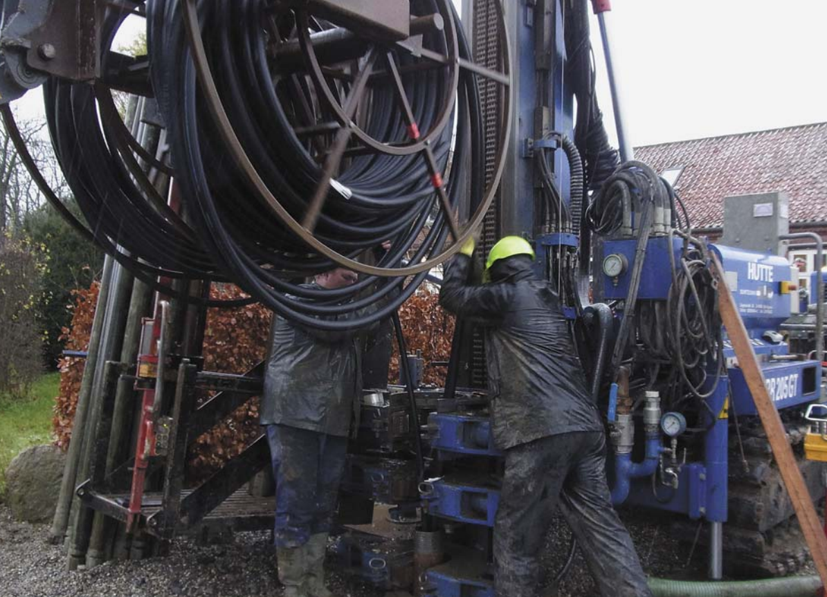
Montering af rør i jordvarmeboring, efter at der er boret 100 meter ned.
